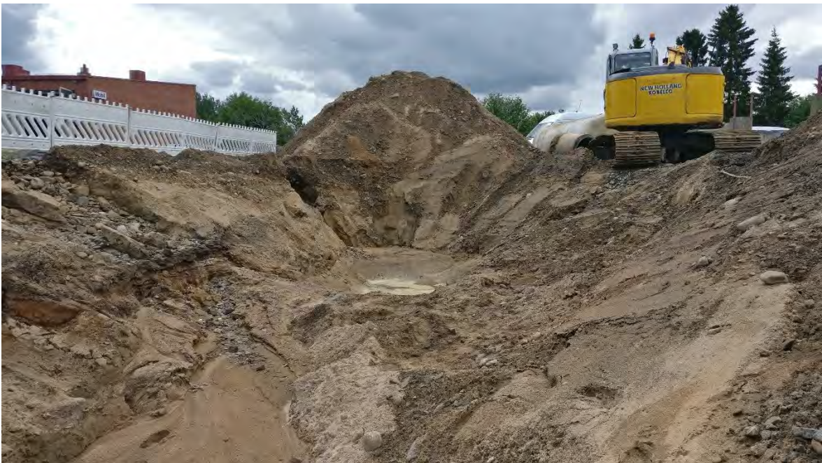
Kuva 4. Toimenpidealue pohjoispäädyistä kuvattuna (8.7.2020).
