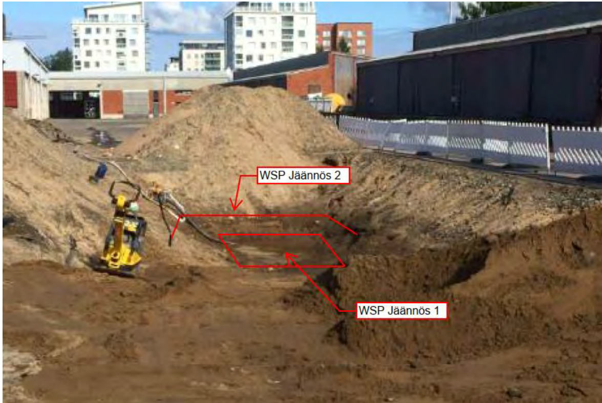
Kuva 6. Jäännöspitoisuusnäytteiden ottopaikat kaivannossa.
