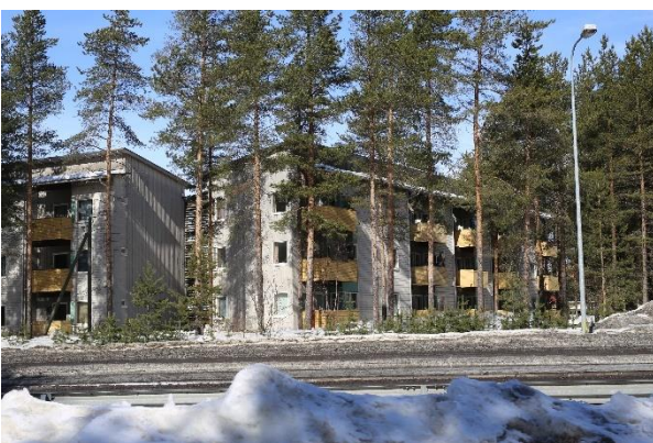
Kuva 58. Puurakentamista Kaijonharjun keskuk- sessä.
