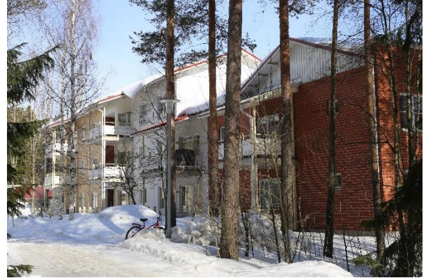
Kuva 59. Asuinrakennuksia Kaitoväylän varrella.
