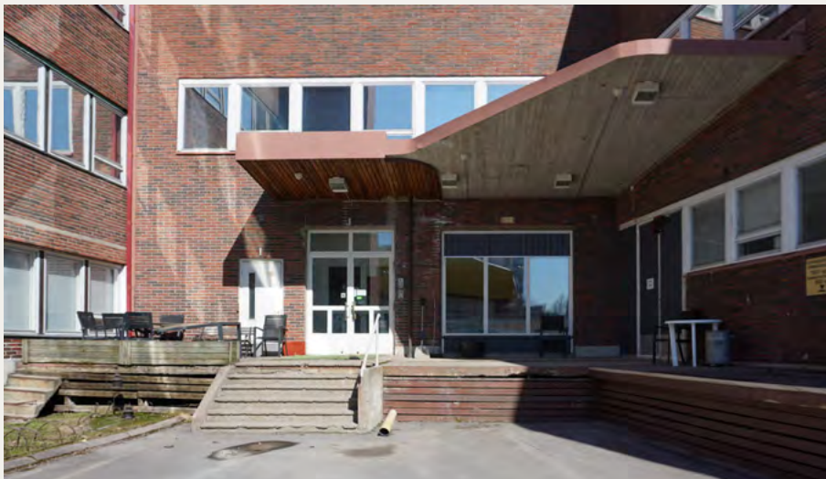
Kuva 75. A2 Terrassoitu sisäänkäynti, katos ja laitur.
