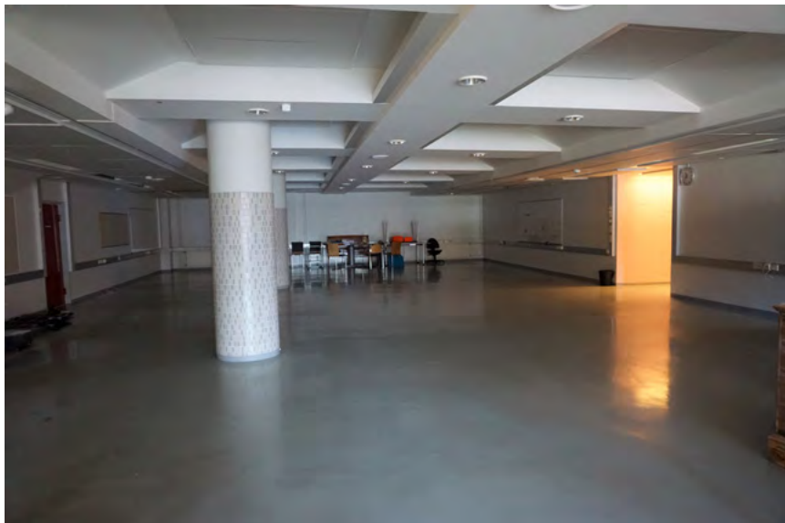
Kuva 97. A2 aulatila kellarikerros. Sisäänkäynti aulaan on alapihalta.
