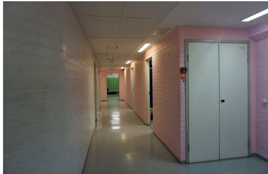
Kuva 99. A2 toimistoja yhdistävä kellarikäytävä.
