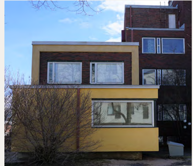
Kuva 76. A1 asuinsiipi, ikkunat Kasarminkadulle.
