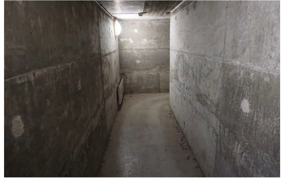
Kuva 112. A3 Käytävä kellarista autohallia kohti.
