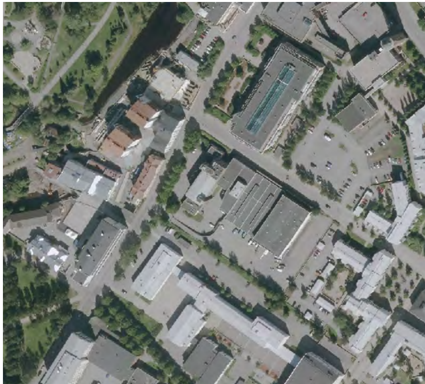
Kuva 57. Ilmakuva 2017. Lähiympäristön Lasaretiin väylän voimalaitos, lämpökeskus sekä sähkölaitoksen konttori sekä läheinen Oulun kansainvälinen koulu 2000-luvun alussa. Lähde: kartta.ouka.fi
