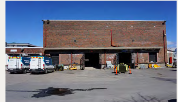
Kuva 68. B osan eteläpääty.
