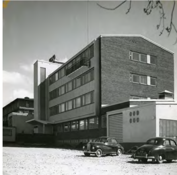
Kuva 38. Konttoriosa A ja talonmiehen asutosiipi päädyssä 1950-luvulla. Lähde: Suomen Tiiliteollisuusliitto, ELKA.
