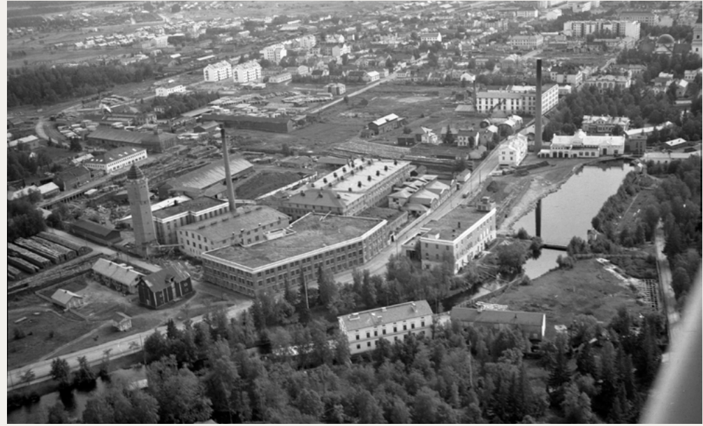
Kuva 17. Viistoilmakuva Åströmin tehdasalue 1940-luvulla ennen Keskon konttorin ja varastorakennuksen valmistumista. Lähde: PPM.
