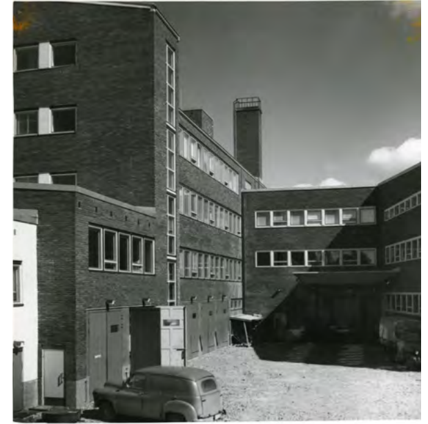
Kuva 40. Konttoriosan A ja varasto-osien muodostama alapiha 1950-luvulla. Lähde: Suomen Tiiliteollisuusliitto, ELKA.
