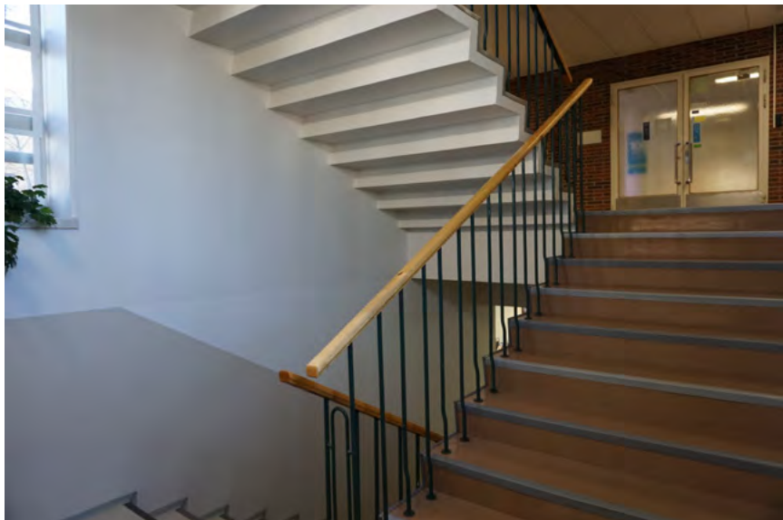
Kuva 89. A1 porrastornin kaksivartiset raput toiseen kerrokseen. Alkuperäinen pinnakaide ja puukäsijohde.
