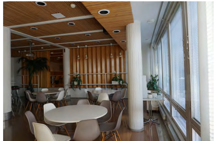
Kuva 80. A1 ruokailutila. Pylväiden pinnassa näkyvillä muottilaudoituksen jäljet.
