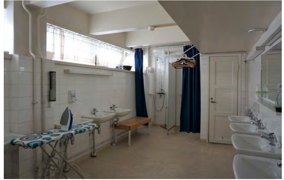
Kuva 83. A1 sosiaalitilat kellarikerroksessa. Vanhat puukehysovet ja lattian hunajakennolaatta ovat todennäköisesti alkuperäiset.
