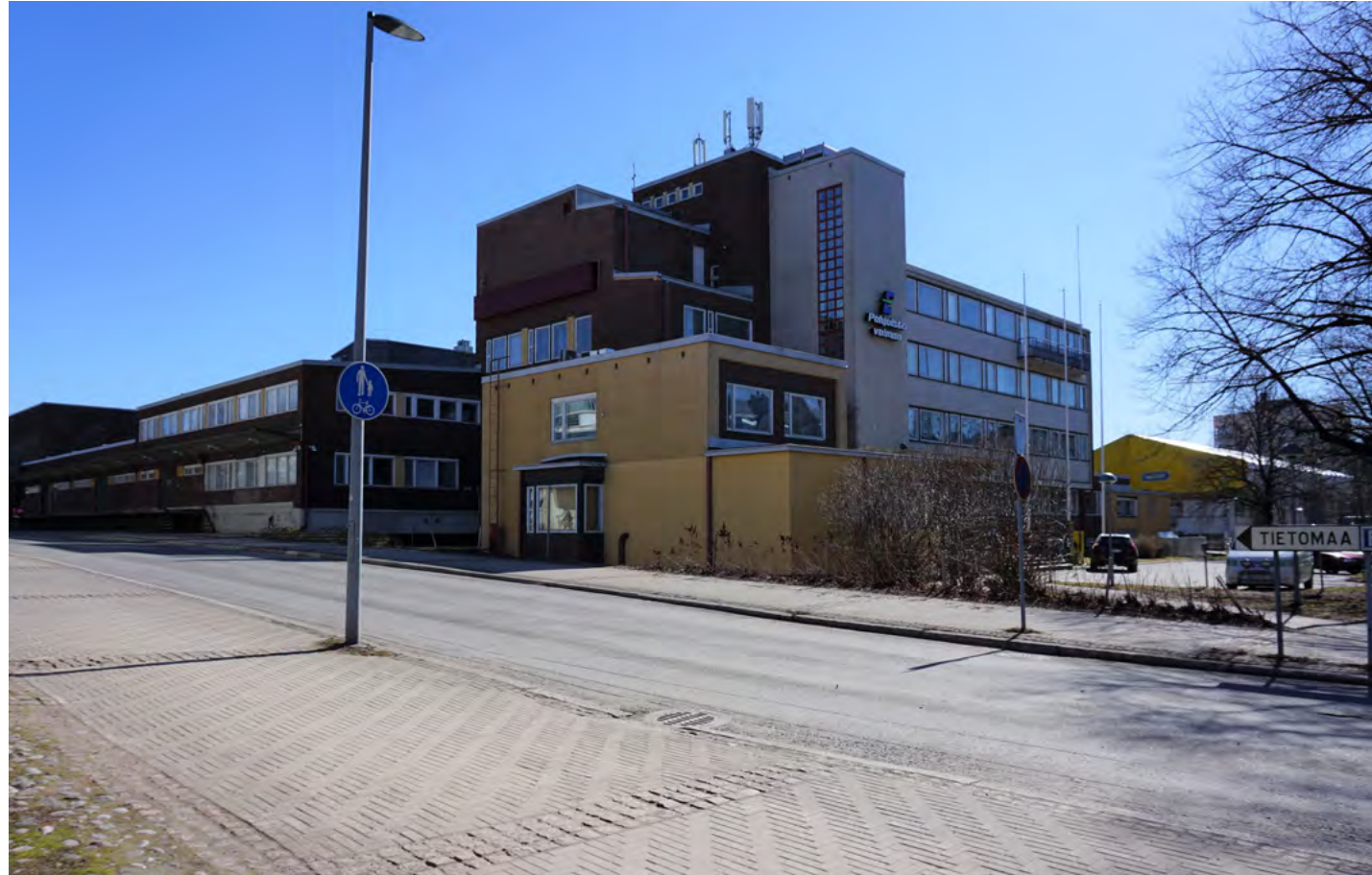
Kuva 64. Oulun Energia Makasiinikadun ja Kasarmintien risteyksessä.
