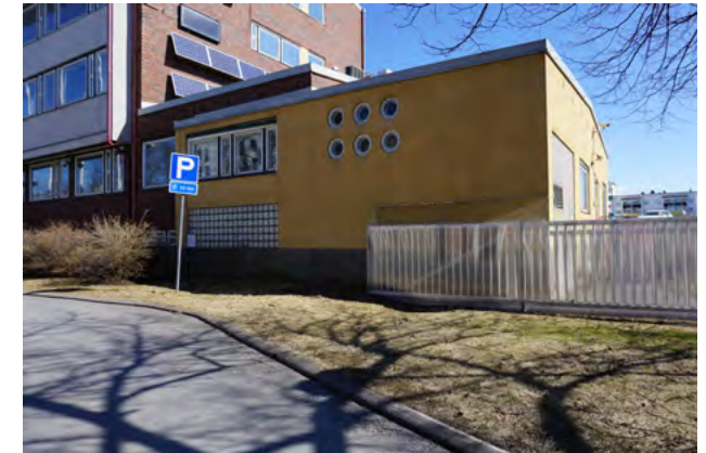
Kuva 73. Talonmiehen asunnon aukotusdetaljit ovat säilyneet alkuperäisinä: lasitiili, keraamiset putkiaukot, ikkunan puitejako.
