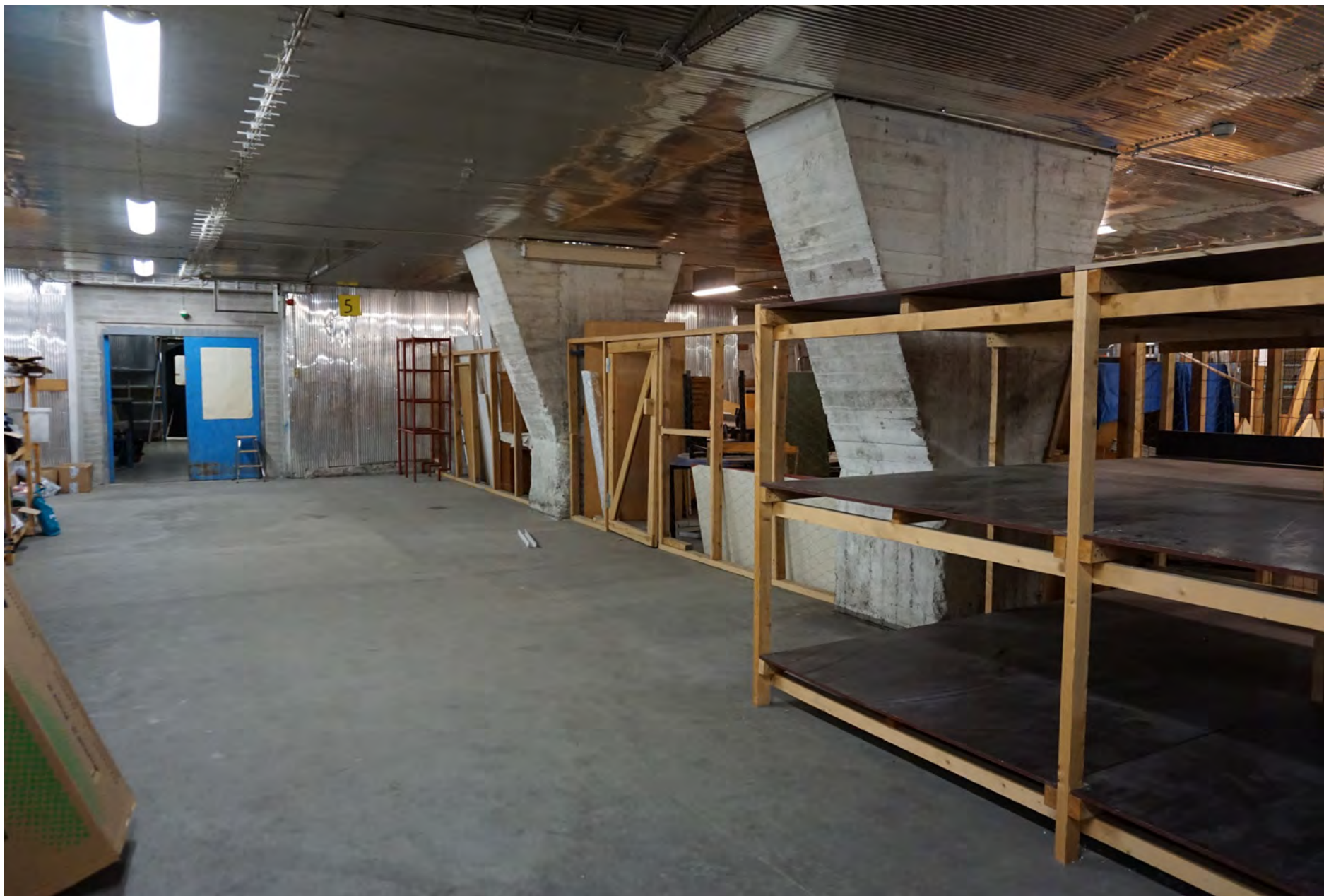
Kuva 109. A3 korjaamot kellarikerroksessa. Laatan tukipilareissa näkyvillä valumuottien jäljet.
