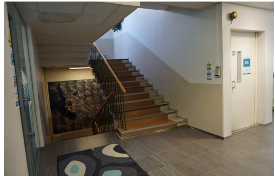
Kuva 88. A1 Väliaula ja rappu porrastorniin 1 kerros; oikealla entinen konttoripäällikön asuinsiipi.
