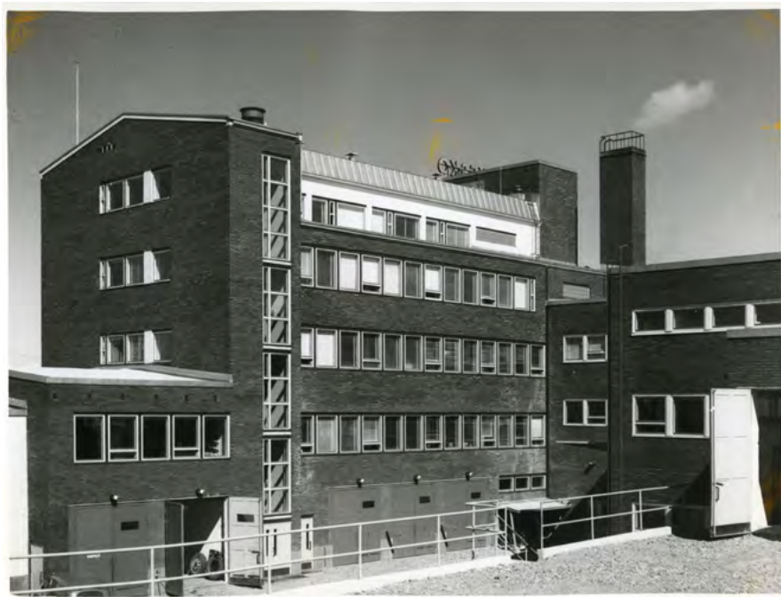
Kuva 41. Konttoriosa A kuvattuna yläpihalta länteen 1950-luvulla. Lähde: Suomen tiiliteollisuusliitto, ELKA.
