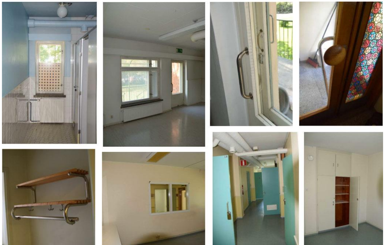
Kuva 5. Allitie 1, valokuvia sisätiloista. Kuva: FCG Suunnittelu ja tekniikka Oy.
