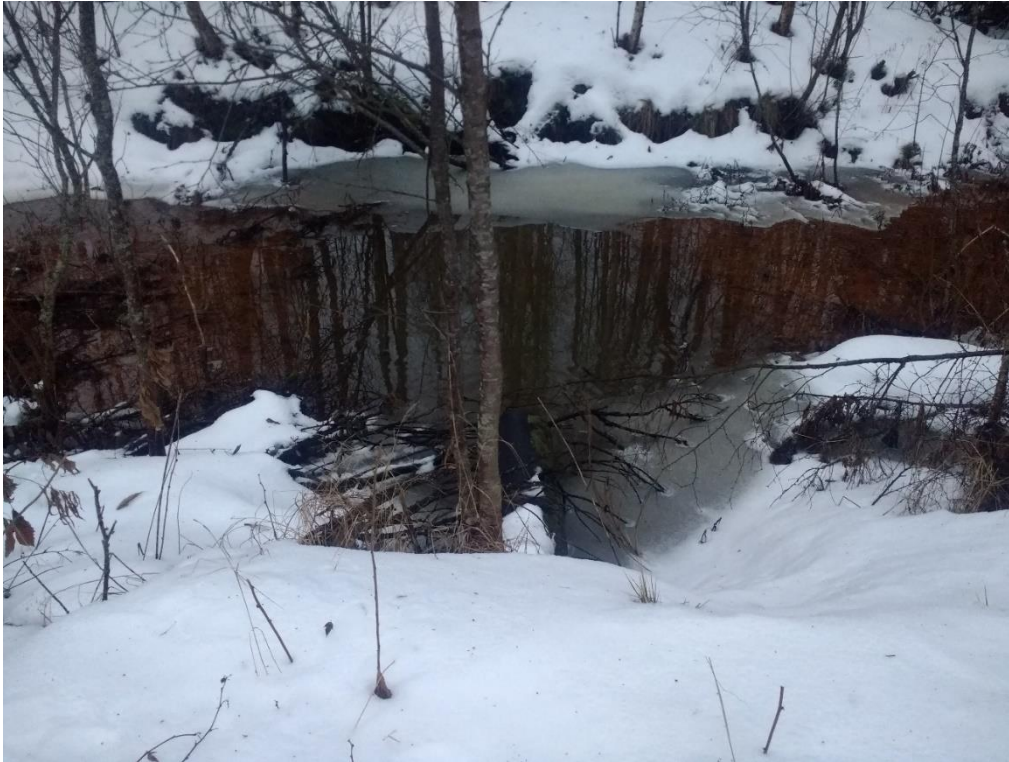
Kuva 4 Vihikari 10 kiinteistöltä tuleva hulevesiputki.
