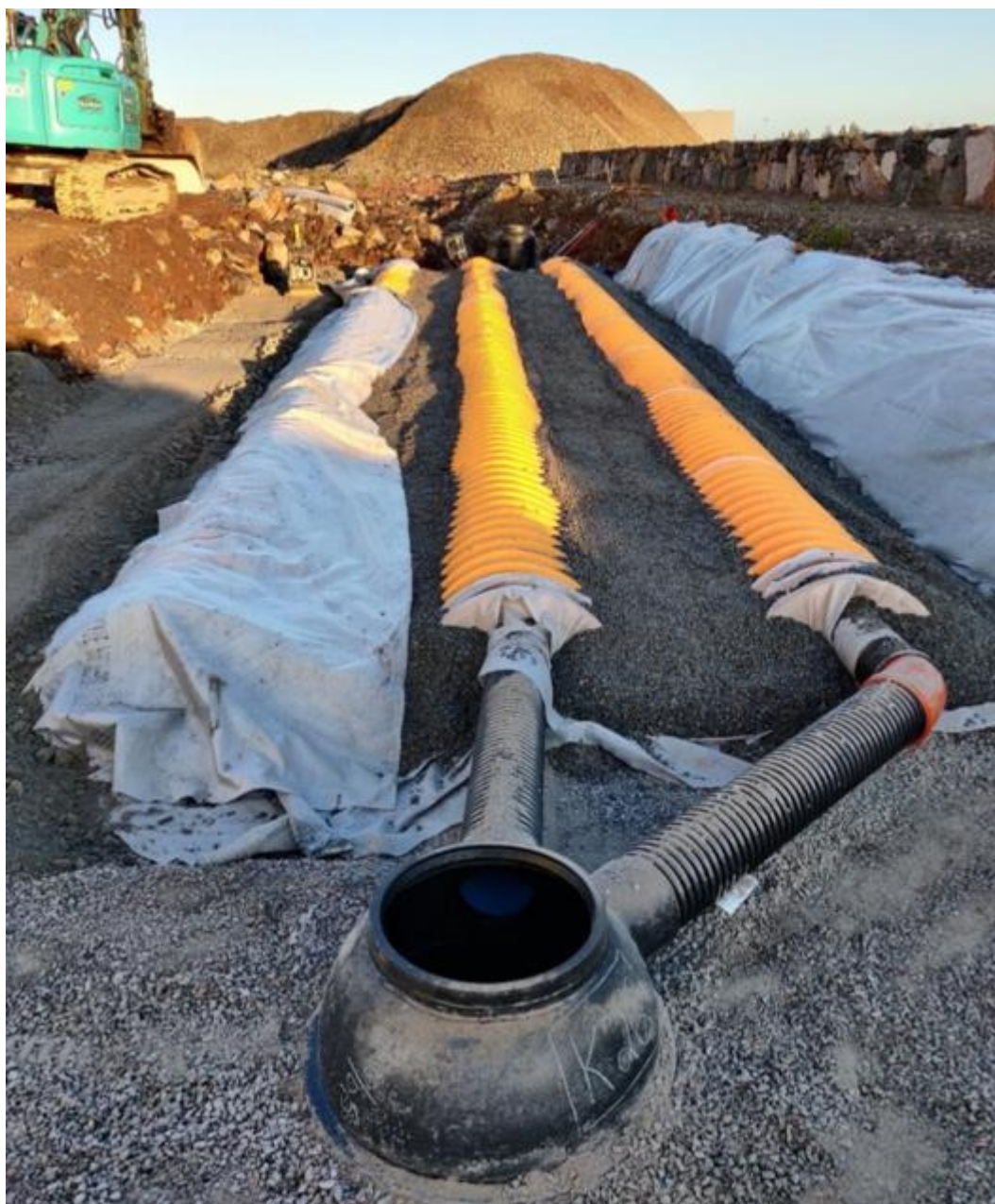
Kuva 7 Hulevesitunneli. Kuva: Viacon Oy.
