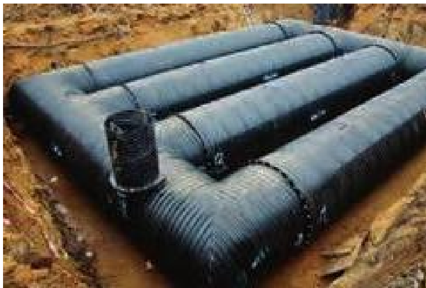
Kuva 3. Hulevesisäiliö. Lähde: ViaCon Oy.
