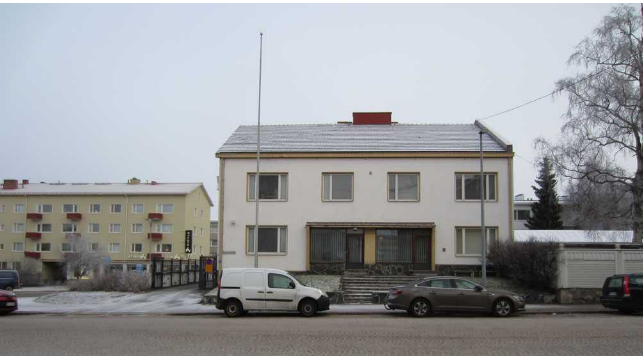
Kuva: Vuonna 1951 valmistunut pienkerrostalo.
