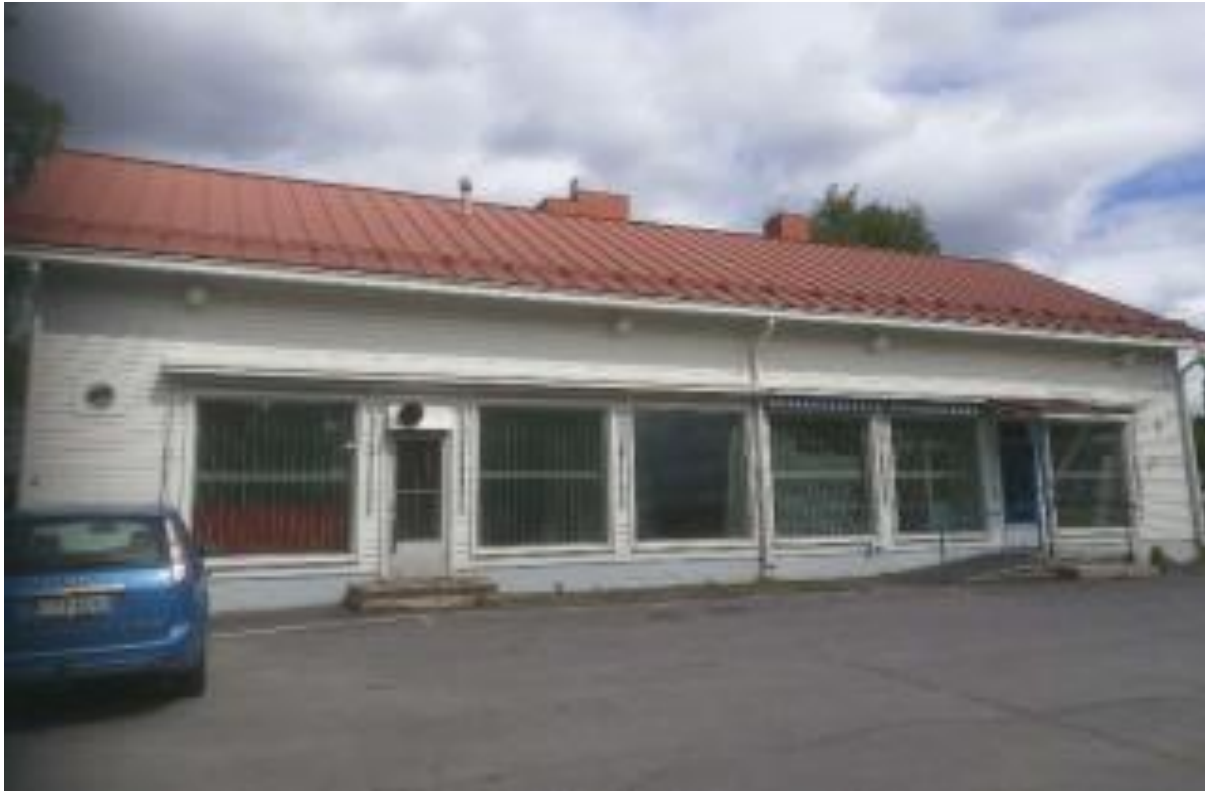
Kuva 12. Myymälärakennuksen julkisivu Kiskotielle (A-Insinöörit 2018)
