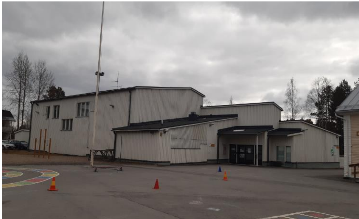
Kuva 10. v. 1982 (B) valmistunut rakennus, jossa sijaitsee mm. koulun ruokala ja liikuntasali.
