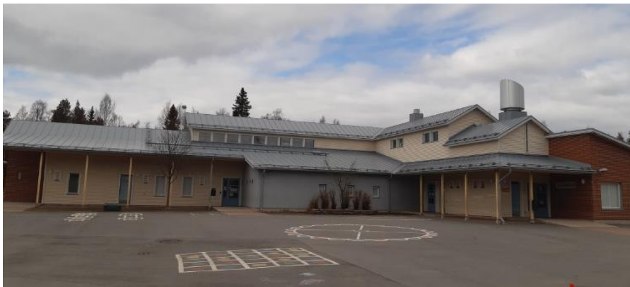
Kuva 11. V. 2006 (C) valmistunut yksikerroksinen koulurakennus.
