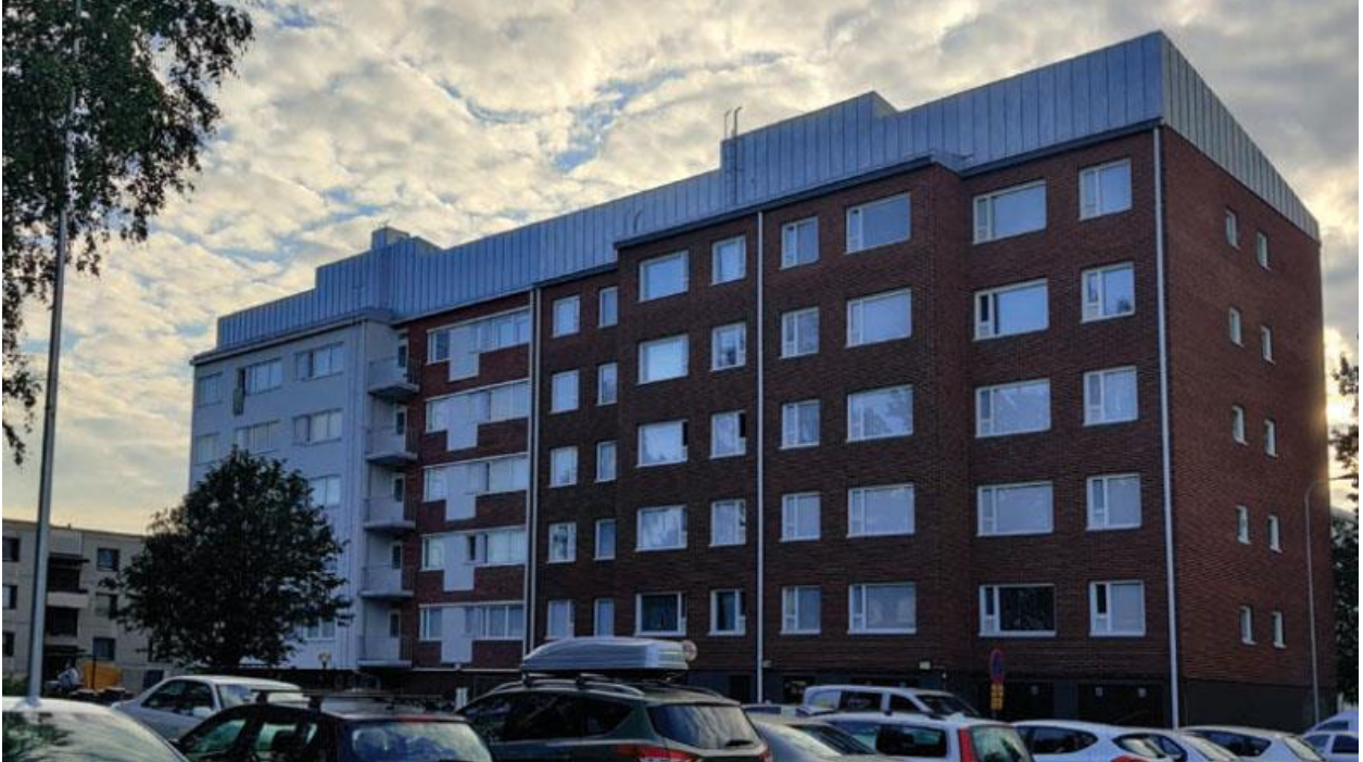
Kuva 6. Näkymä kaakosta. Oikealla Torikatu 39 ja vasemmalla Torikatu 51. Kuva: Heini Hiukka.
