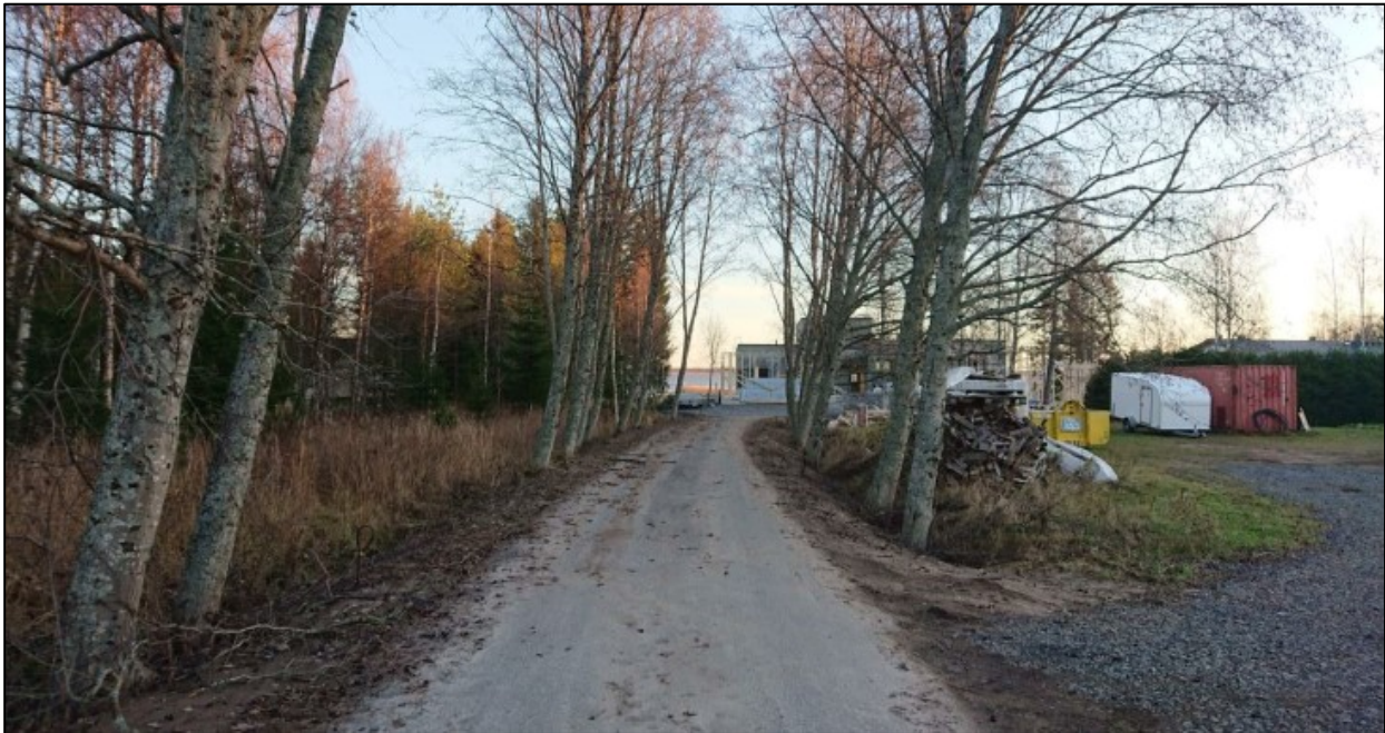
Kuva 9. Niementie 28:n kuja pihaan. Kuvaaja Minna Takalo FCG Finnish Consulting Group Oy
