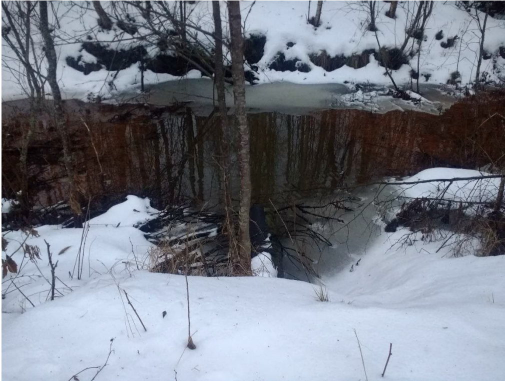
Kuva 4 Vihikari 10 kiinteistöltä tuleva hulevesiputki.
