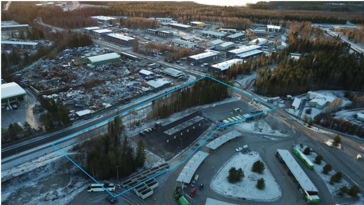
Kuva 6-2. Kaavamuuotosalue (rajattu kuvaan) jätekeskuksen suunnasta nähtynä. Etualalla vasemmalla näkyvä metsikkö raivataan pois tankkausaseman laajennuksen tieltä.
