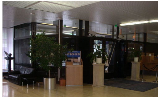
Itsepalveluautomaattien yleistyessä tuulikaappia laajennettiin vuonna 1987. Runkorakennetta vahvennettiin ja näkyvyyttä ulos suljettiin.
