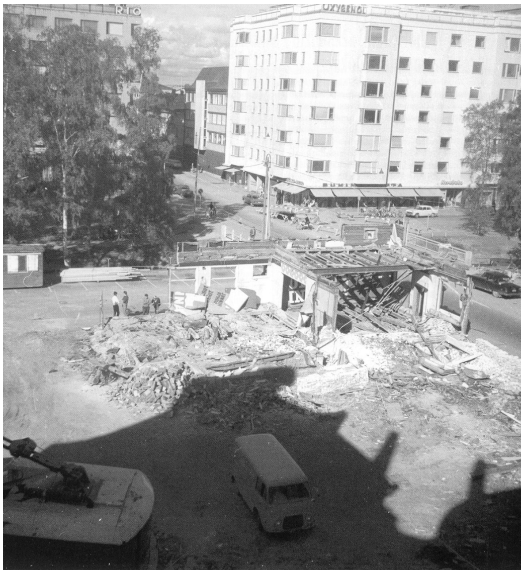
Osuuspankin rakentaminen käynnissä kesällä 1970. (Atte Kalajoen arkisto, Puistola )
