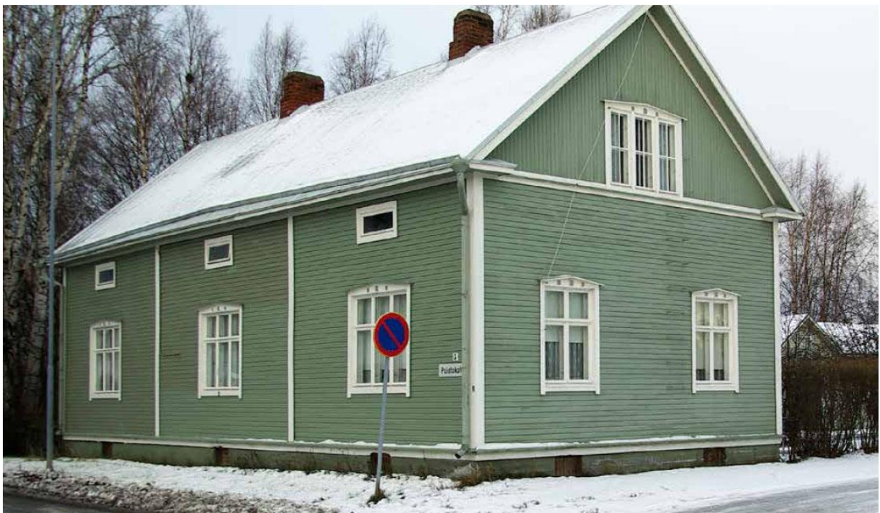
Kuva 2. Asuinrakennus, kuva rakennushistoriaselvityksestä. Kuva: Arkkitehtitoimisto Jorma Teppo Oy.
