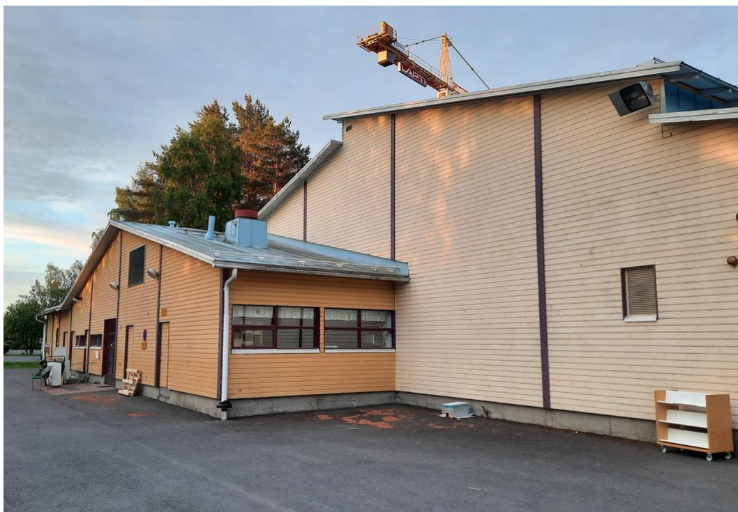
Kuva 5. Entinen Välivainion koulurakennus. Ilmastoinnin tuuletusritilä näkyy seinällä, kuvan vasemmassa reunassa.
