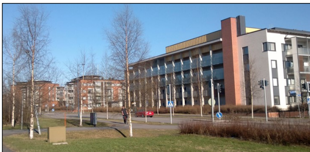
Kuva 9. Kaakkurinojantien varren asuinrakennuksia.
