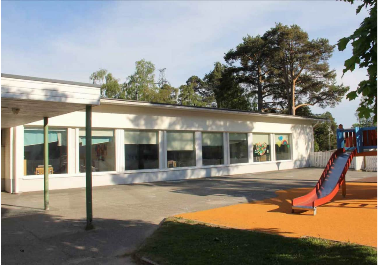
Merikosken päiväkoti. Kuva Arkkitehtitoimisto Jorma Teppo Oy / Veli-Pekka Huhmo.
