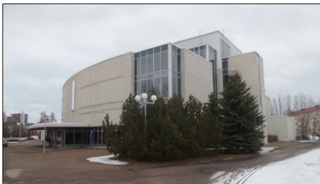
Kuva 11. Näkymä pääsisäänkäyntiin etelän suunnasta (RHS).
