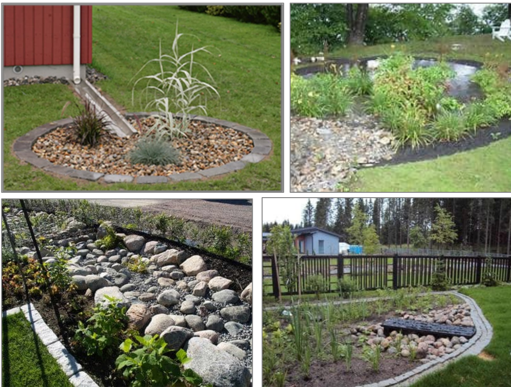
Kuva 25 Esimerkkejä hulevesien imeytysohjauksista (sadepuutarhoista), joissa yhdistetty kasveja ja seulanpääkiviä.
