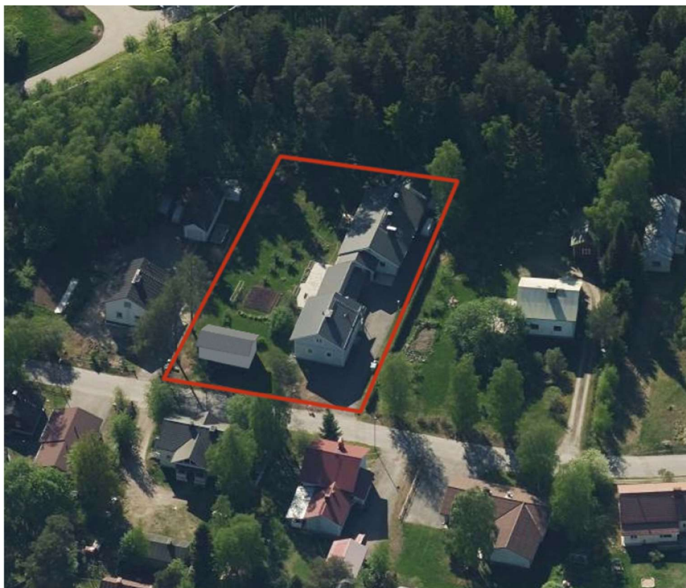
Kuva 6. Ilmakuva suunnittelualueesta idästä katsottuna. Olemassa olevat rakennukset ovat tontin pohjoisreunassa ja uusi autotalli-/varastorakennus on sijoitettuna Kelotien varteen.
