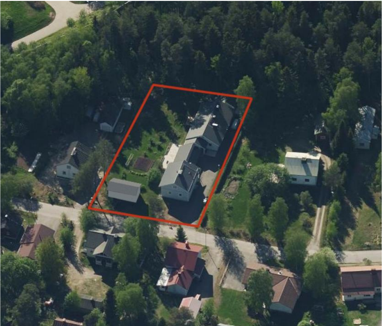
Kuva 7. Ilmakuva alueesta idästä katsottuna. Olemassa olevat rakennukset ovat tontin pohjoisreunassa ja uusi autotalli-/varastorakennus sijoitettuna Kelotien varteen.
