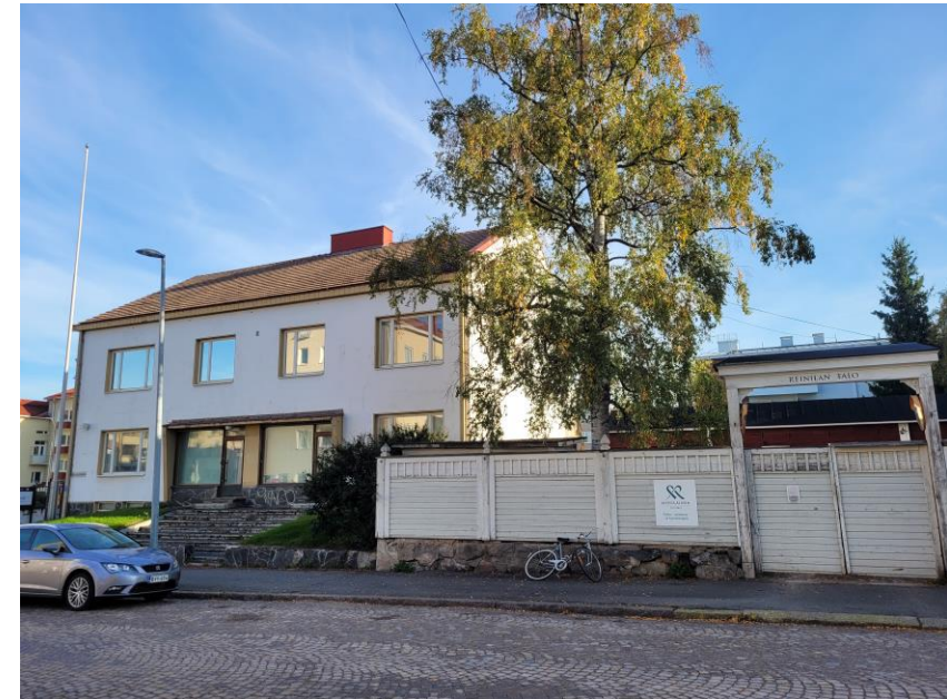
Kuva 15. Asemakaavamuutosalue nykyisin ja viereisen Reinilän talon nykyinen aita ja portti. Porttia tulee suurentaa puomitikasautolle sopivaksi.
