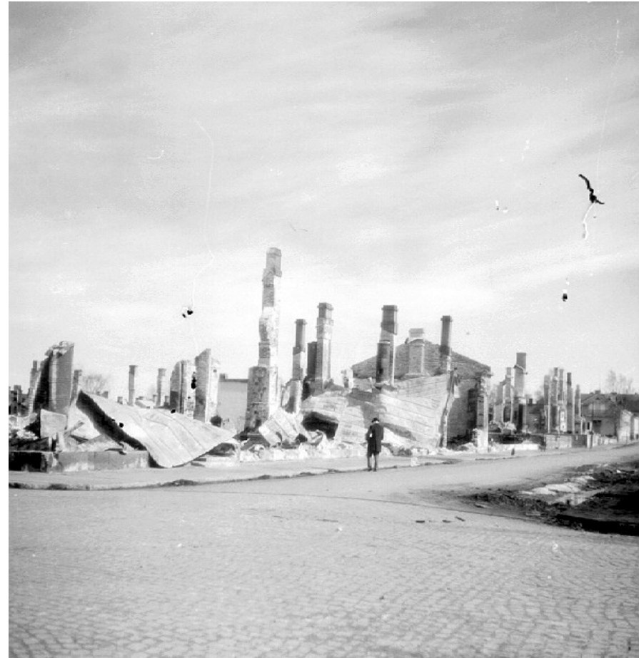
Kuva 5. Pommituksien vaurioita Isokadun ja Kajaaninkadun kulmauksessa v.1945.
