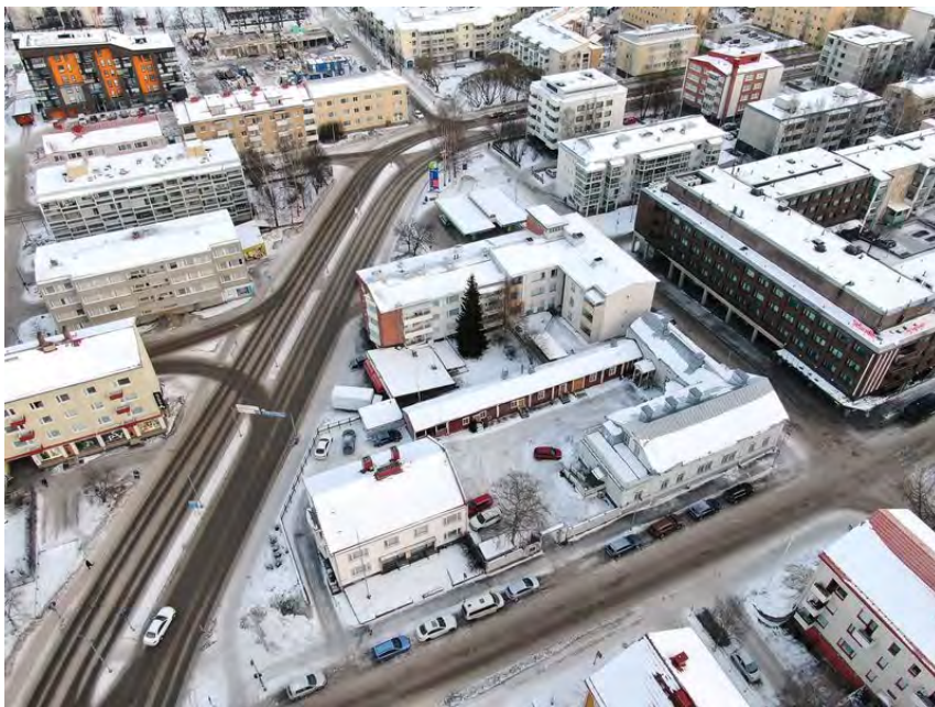
Kuva 13. Ilmakuva korttelin 3 rakennuskannasta.
