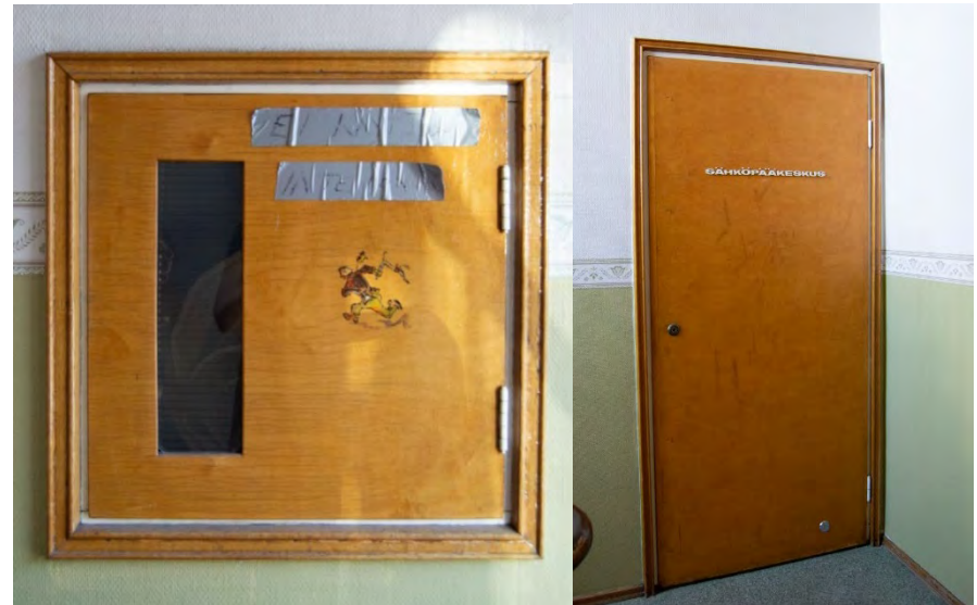
Kuvat 30 ja 31. Säilyneitä rakennusosia porrashuoneessa: pikapalopostin luukku ja ovi.
