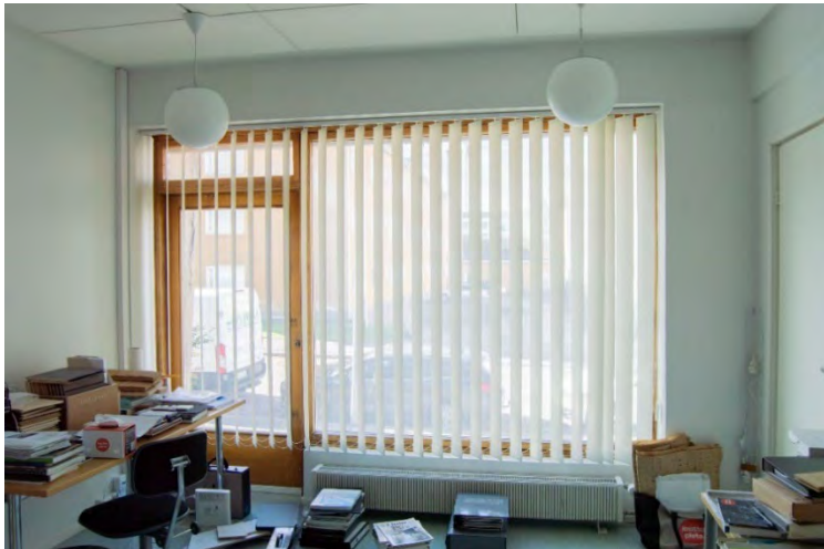
Kuva 29. Ensimmäisen kerroksen Kajaaninkadulle avautuvan liiketilan alkuperäisinä säilyneet puuikkunat ja -ovi.
