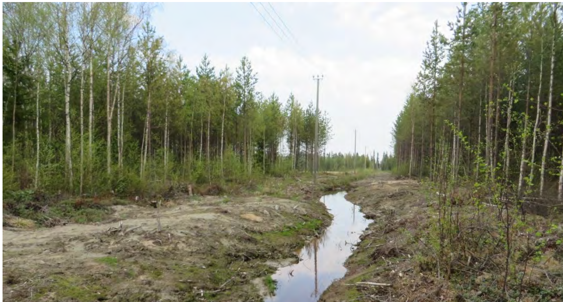
Kuva 15. Uusi voimajohto, oja ja viemäriinjan kaivualue jakavat metsäalueen kahteen osaan.
