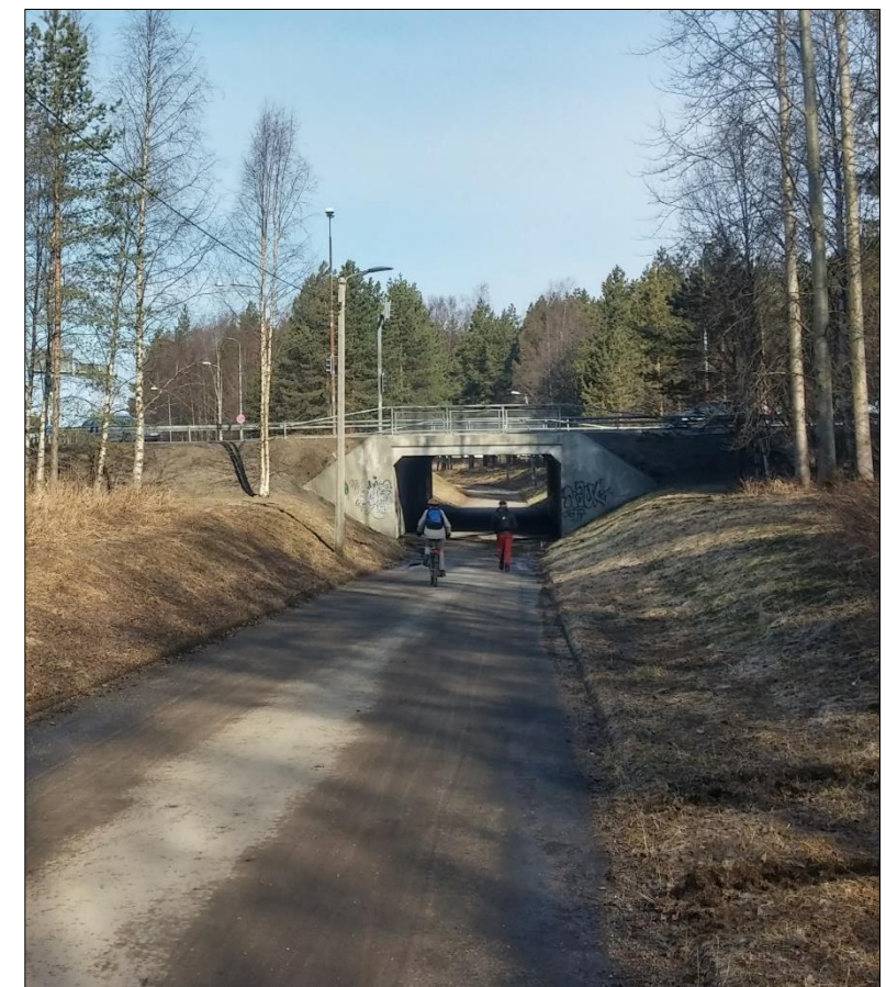
Kuva 9. Kemintien alittava alikulku Tervahovintien liittymässä.
