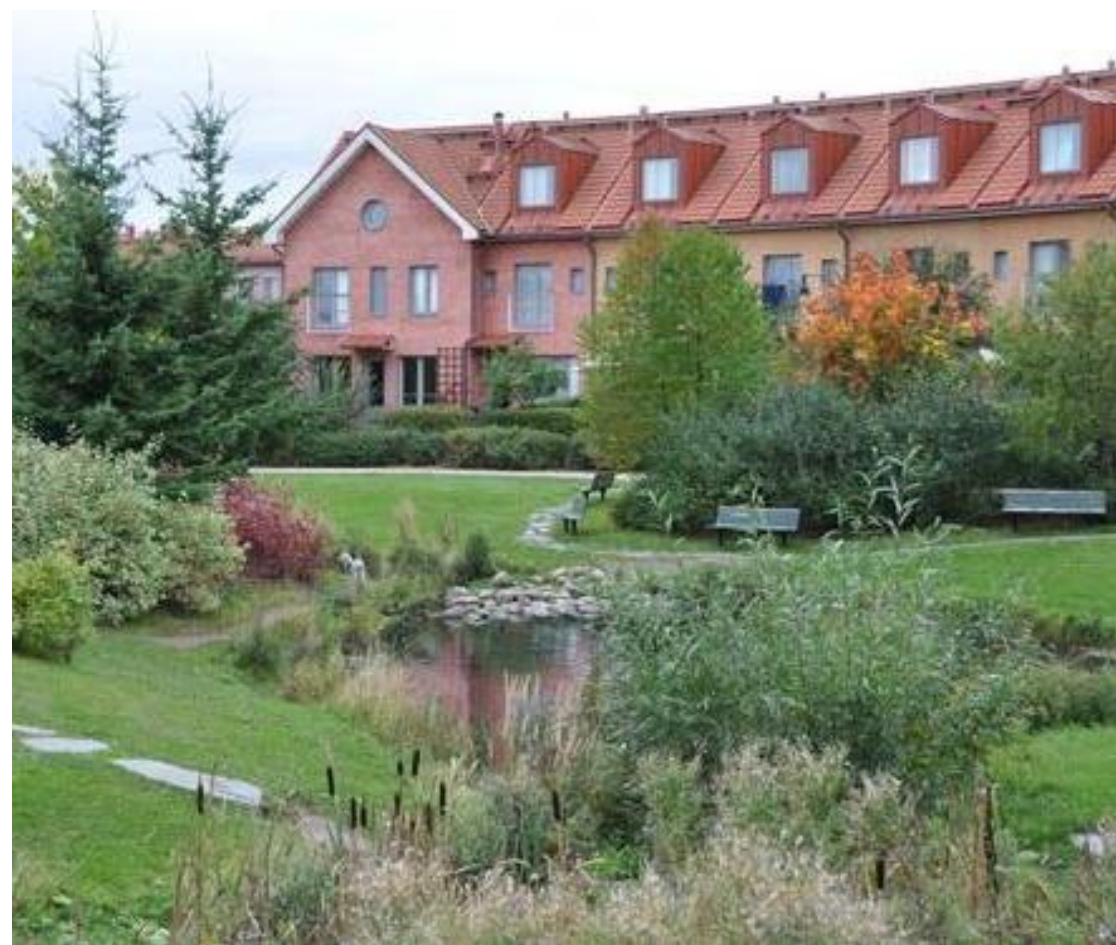
Kuva 30. Puistoalueella oleva hulevesien viivytyks ja laskeutusallas.
