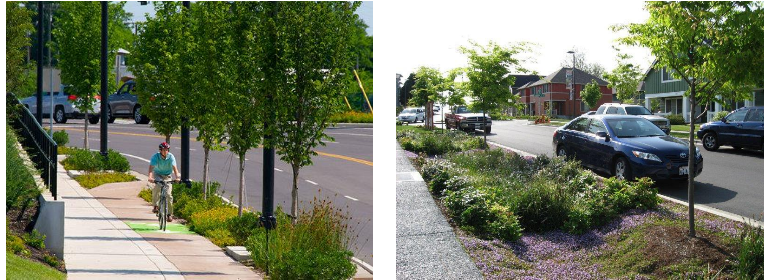
Kuva 25. Viivyttävät ja imeyttävät viheralueet jalkakäytävän ja ajoradan välissä. Istutus kerää molemmilta väyliltä pintavalunnan ja suodattaa veden ennen salaojaa. Kasvit auttavat puhdistamaan hulevesiä sekä haihduttavat osan siitä. (Green street design manual)
