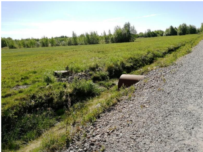
Kuva 8 Kaakkurinoja, huoltotien rumpu.
