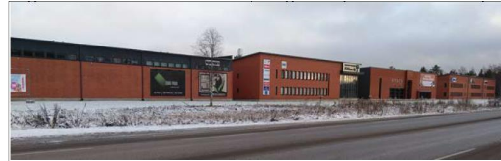
Kuva 41. Kaupunkikuvallisesti hyvä esimerkki onnistuneesta toteutuksesta Vaalantien varressa.
