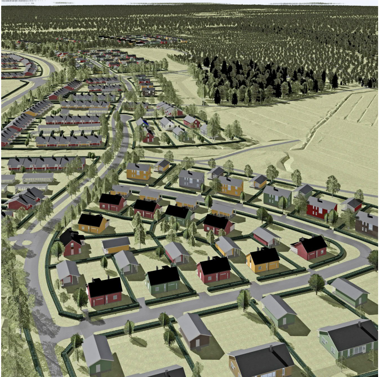
Näköala alueelle pohjoisesta
