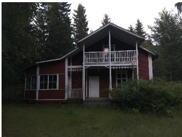
Kuva 4. Vaaskiventie 22:n vanha päärakennus.
