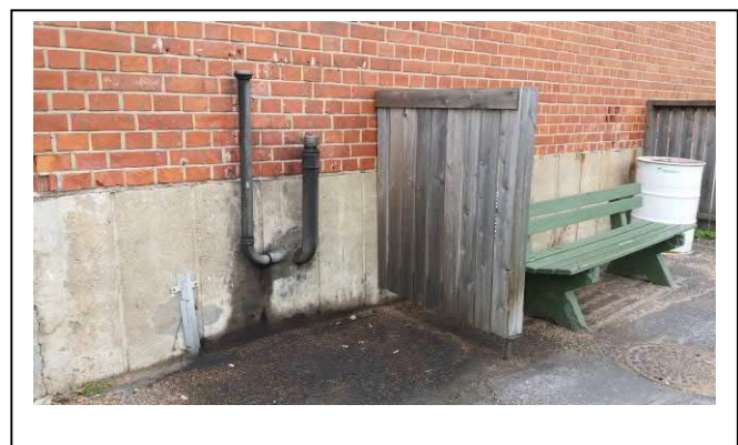
Kuva 17. Lämmitysöljysäiliön täyttöpaikka
