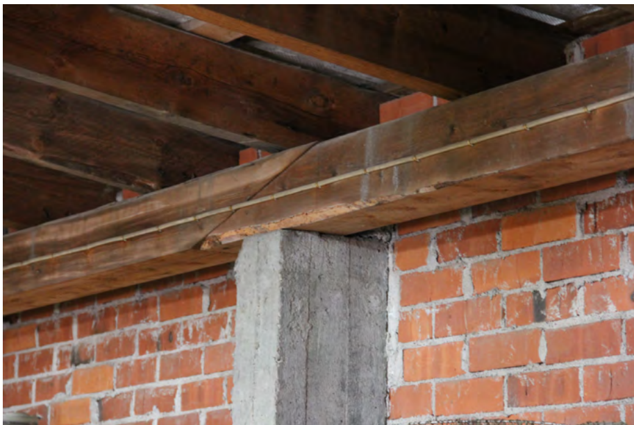
178. Betonipilarit kannattelevat puista vesikattorakennetta.
