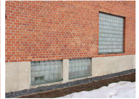
89. Lasitiili-ikkunat toimistosiiven eteläpäädyssä.
