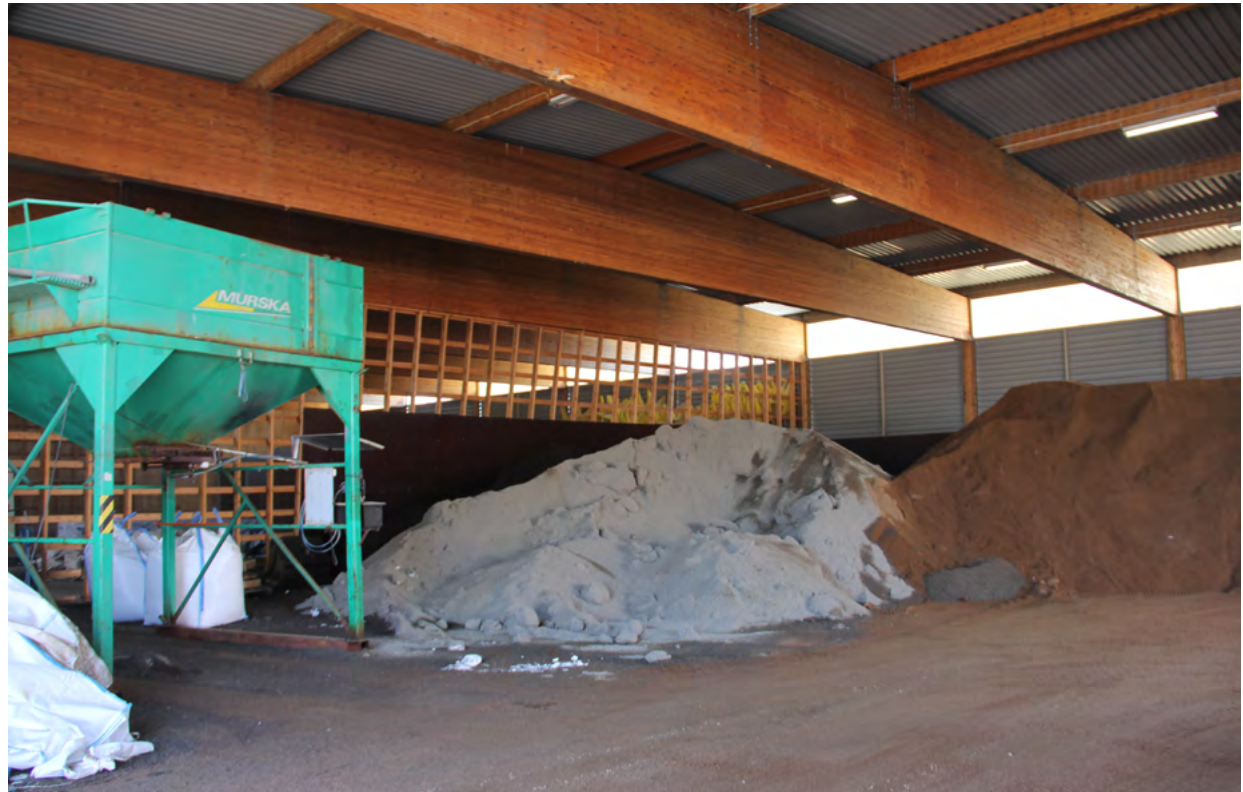
180. Varastohallin järeitä liimapuurakenteita.
