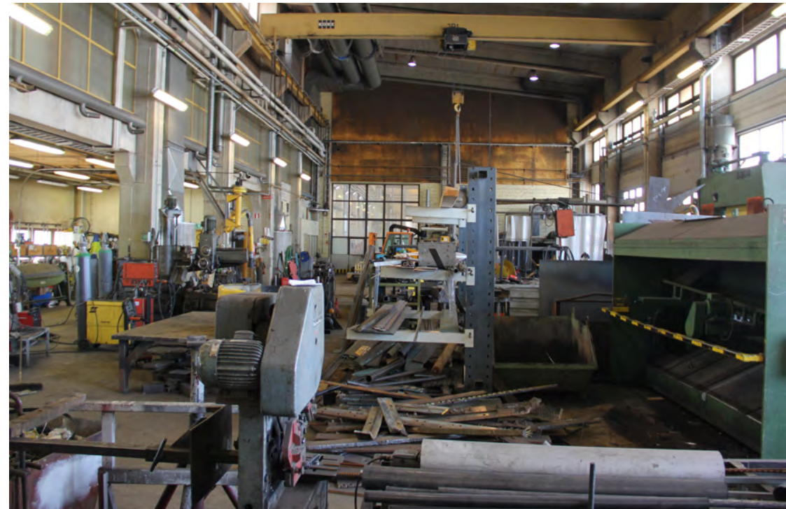
152. Korjaamohalli pohjoispäästä nähtynä.
