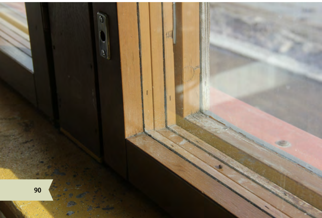
151. Laajennusosan ikkunat ovat kolmilasisia MSK-ikkunoita.
