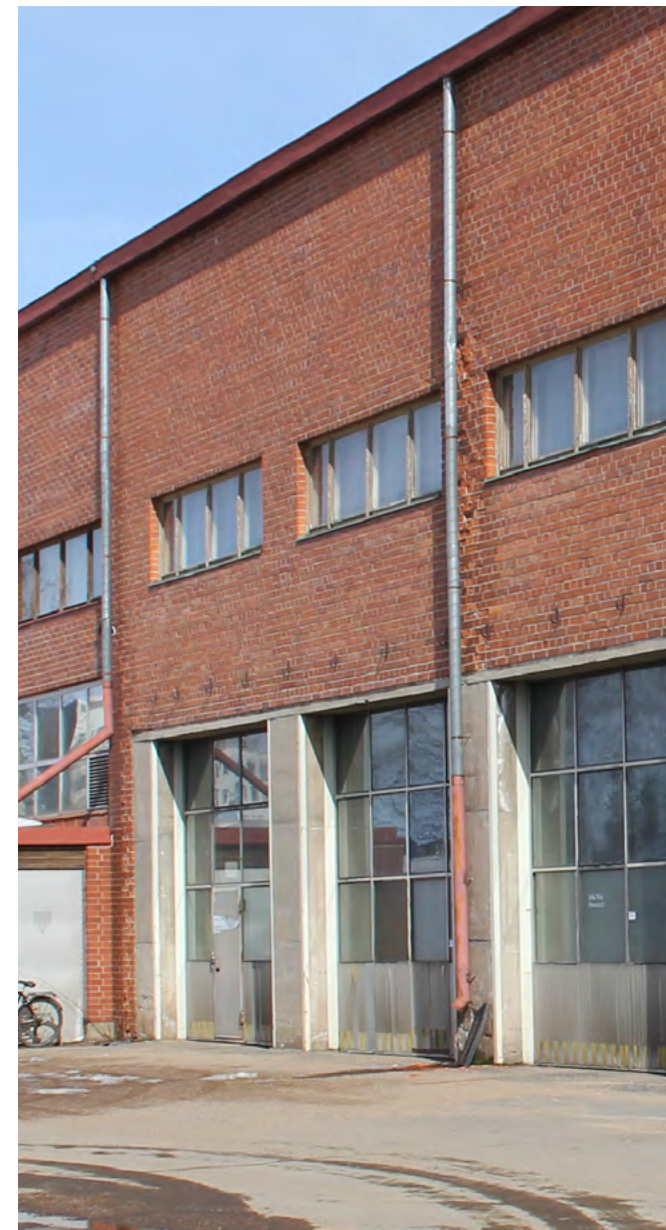
93. Pihan puolella syöksyt johtavat veden ajopihan kuivatusjärjestelmään.
