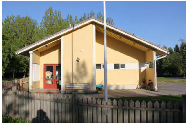
183. Pohjoispääty, jossa pääsisäänkäynti
