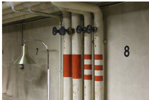
123. Juokseva numerointi seinissä ja lattiassa viittaa varastopaikkoihin.
