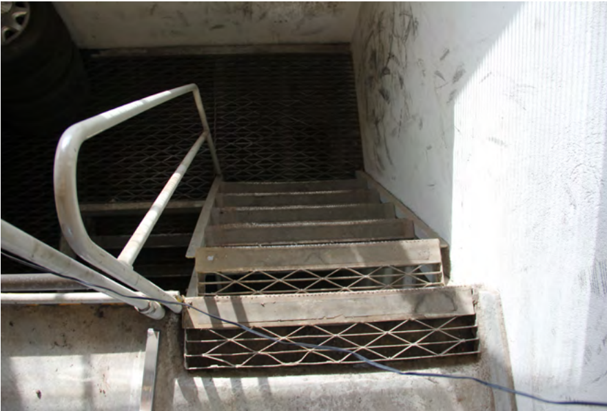
97. Huoltohallista kellariin johtavat alkuperäiset teräsportaat.
