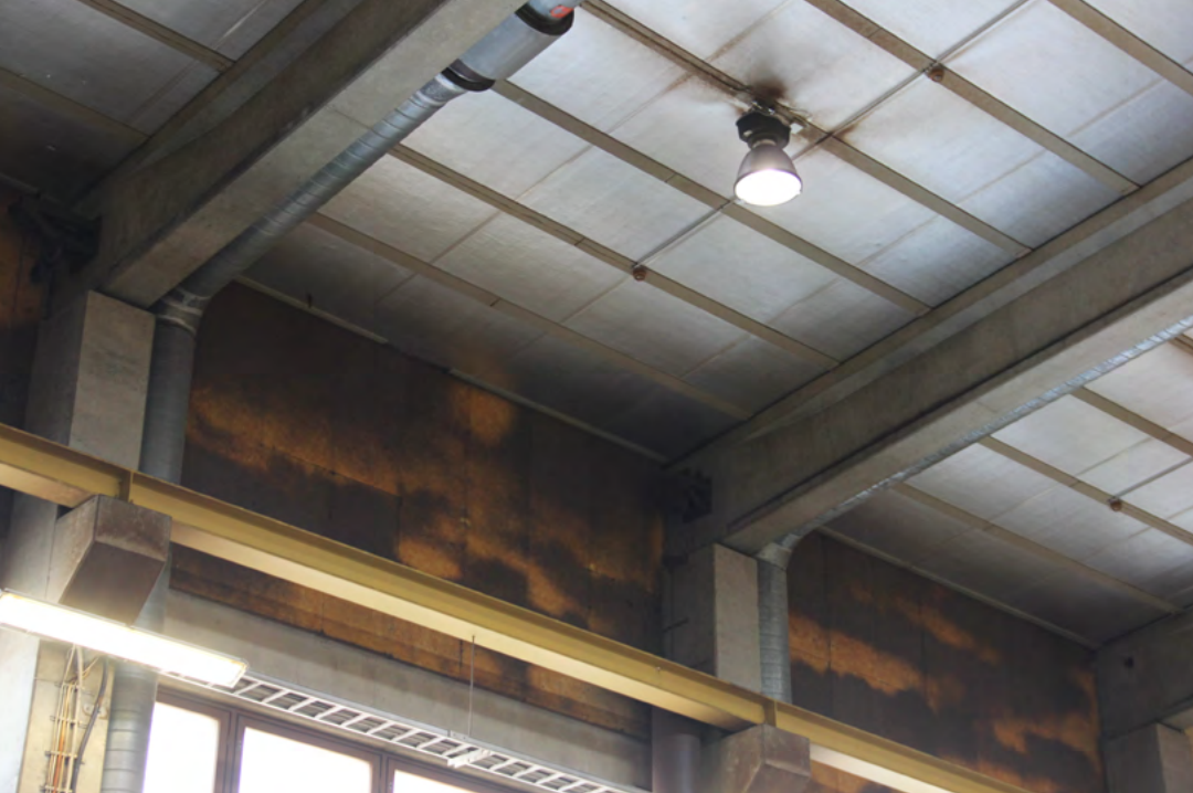
149. Uudemman korjaamohallin järeitä betonisia runkorakenteita.
