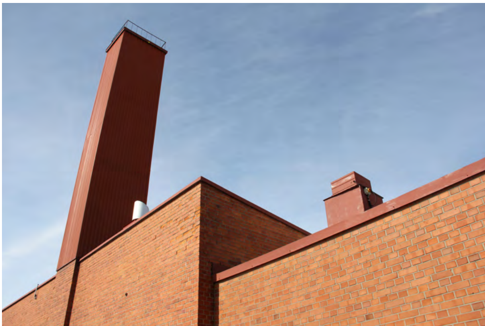
73. Vanhimman osan muurauksessa on käytetty ristilimitystä.
