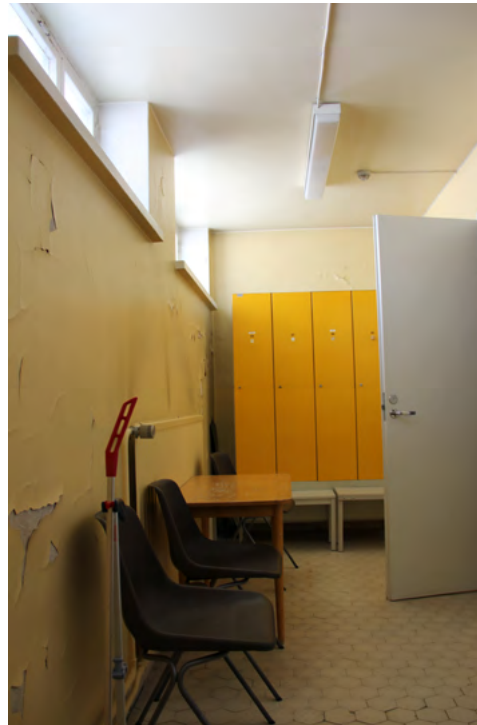
106. Keittiön paikalle rakennettiin lisää sosiaalitiloja.
