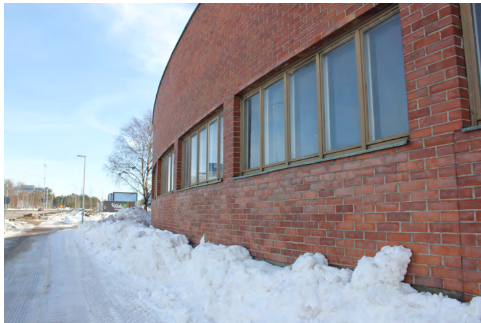
74. Laajennusosan julkisivuissa on 1970-luvulle tyypillinen tasalimitys.
