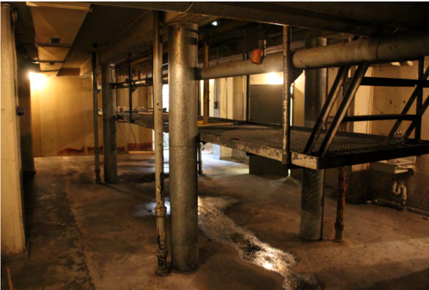
98. Kellarin rasvamonttu on säilynyt alkuperäisenä. Alapuolista huoltosiltaa ei enää käytetä.
