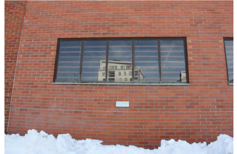
87. Autosuojan laajennuksen ikkunat vuodelta 1982.
