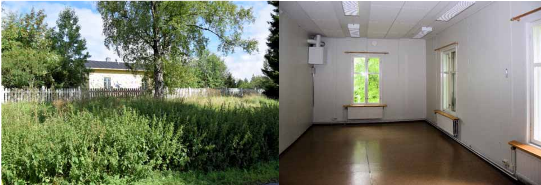
Talo Store julkisivu rannan suuntaan ja sisätila.
