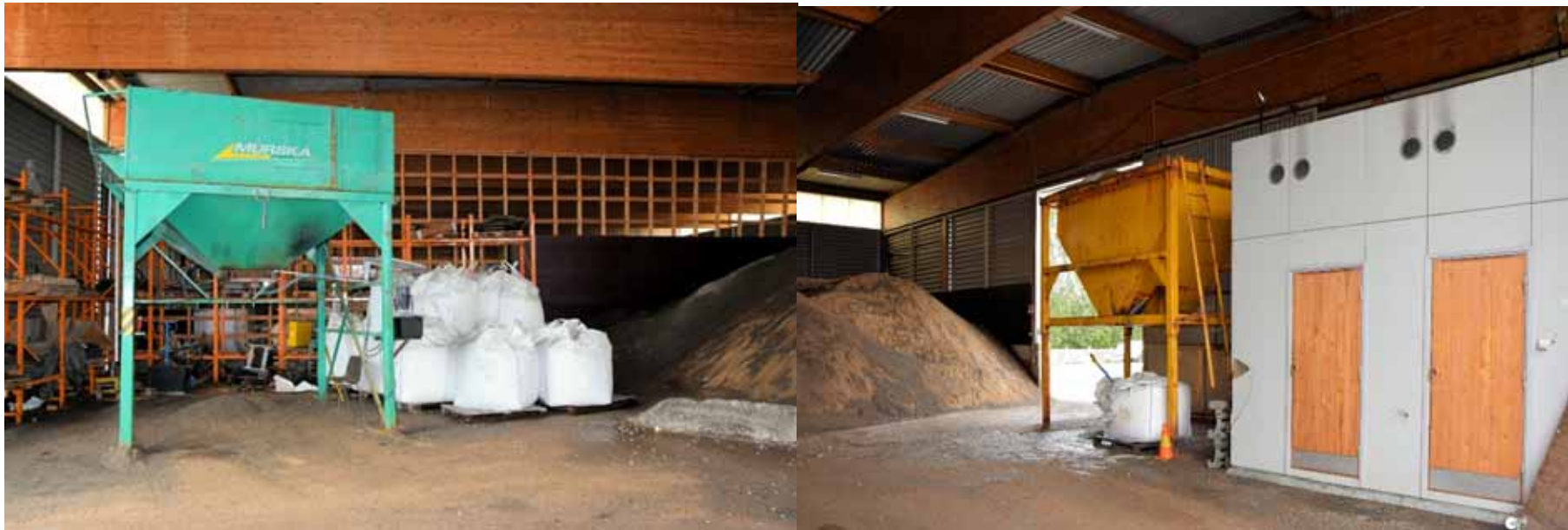
Uudemman hallin sisätilaa:
