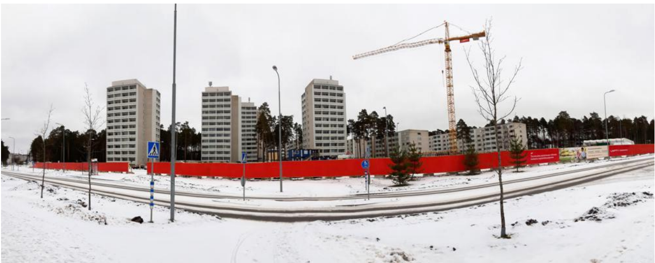
Kuva: Kaava-alueen eteläosan työmaa Sairaalanrinteen varressa alkuvuodesta 2020.
