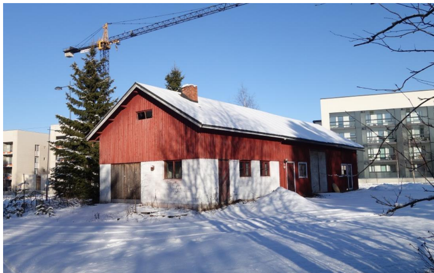
Kuva 2. Tarkistettu latorakennus kuvattu ulkoa 28.2.2020.
