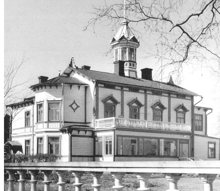
Toppilan Mallasjuomatehtaan huvila 1960-luvulla. (Kuva Niskala 2007, 74). Huvilan nykyinen uusrenessanssityylinen ulkoasu on peräisin vuodelta 1881. Parvekkeen alla oleva veranta on lasitettu 1960-luvun tienoilla.
