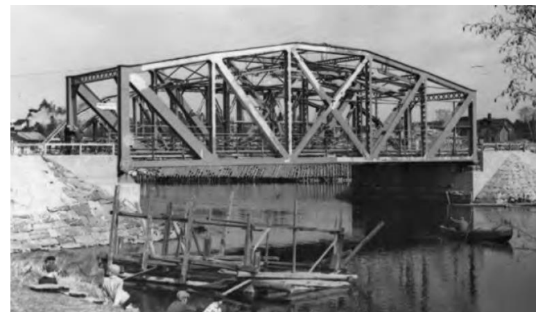
Rautatiesilta Toppilansalmen yli valmistui vuonna 1942. (Kuva Pohjamo 2011, 114. Alkuperäinen lähde Pohjois-Pohjanmaan museo).
