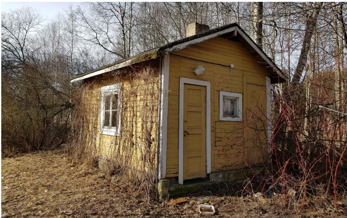
Saunarakennus pihan puolelta.
