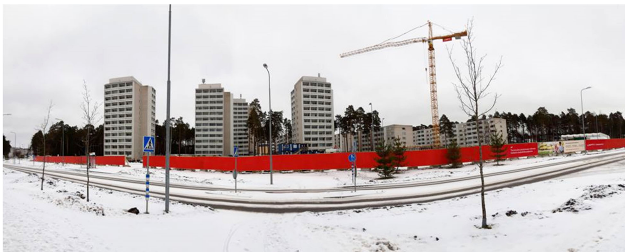
Kuva: Kaava-alueen eteläosan työmaa Sairaalanrinteen varressa alkuvuodesta 2020.
