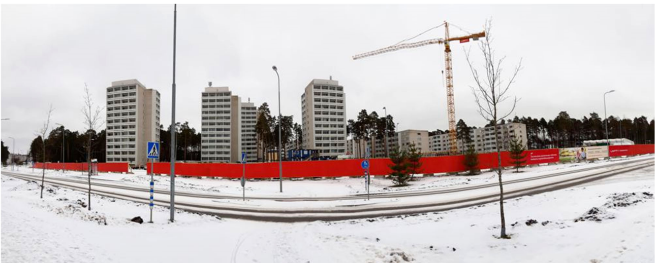
Kuva: Kaava-alueen eteläosan työmaa Sairaalanrinteen varressa alkuvuodesta 2020.
